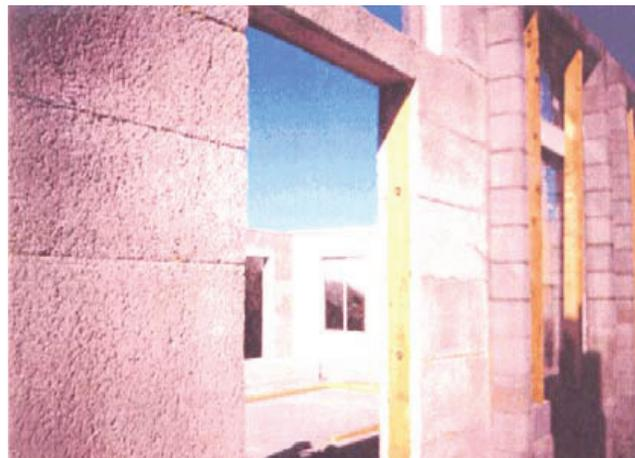
Los bastidores de madera pueden quedar afuera del marco o dentro de este, como se ilustra en la siguiente figura. Independientemente de la forma en que se instalen, se deben insertar soportes para sostener el bastidor y los paneles THERMOWALL PS en su lugar durante el proceso de vaciado del concreto, a fin de garantizar que la presión del concreto no mueva o venza las aberturas.
